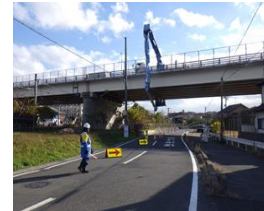
橋梁点検状況
