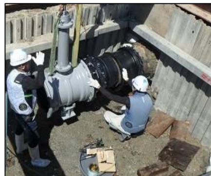
配水管耐震化工事
