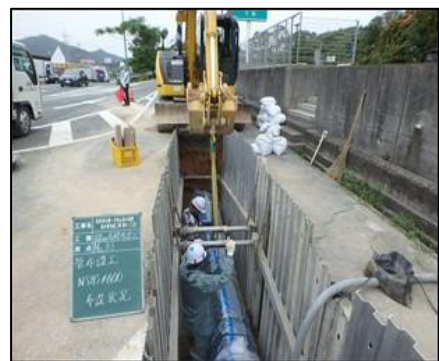
送水管布設工事（長府浄水場～日和山浄水場間）
