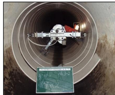
下水道管更生工法（内部の様子）
