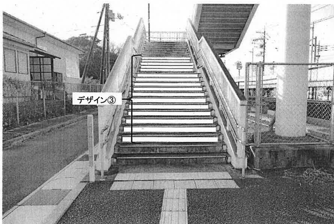
歩道橋 東側階段 16段
