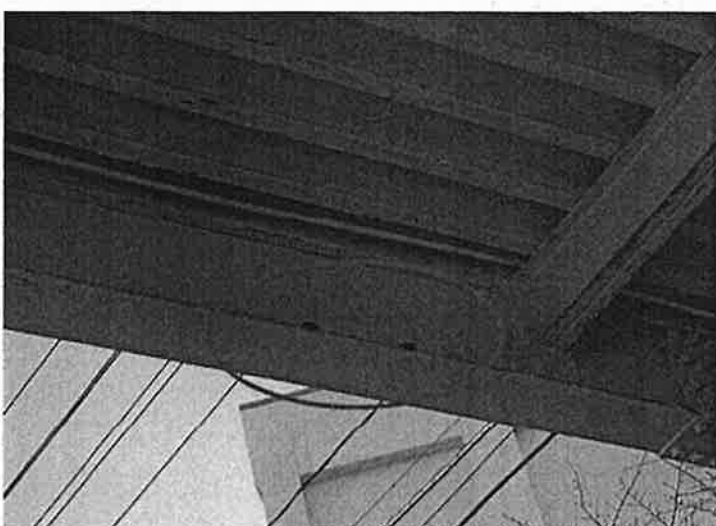
歩道橋底部状況
