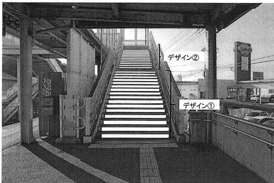
歩道橋 西側階段(駅ホーム側) 16段×2=32段
