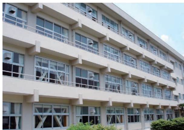
安岡中学校耐震補強
