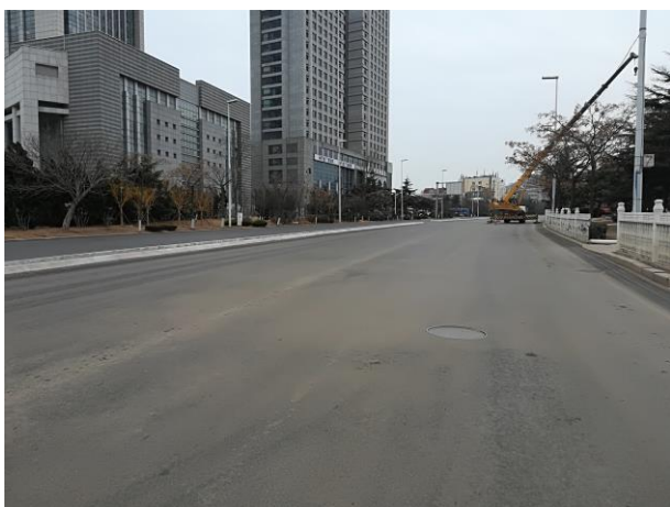
▲道路工事の様子
