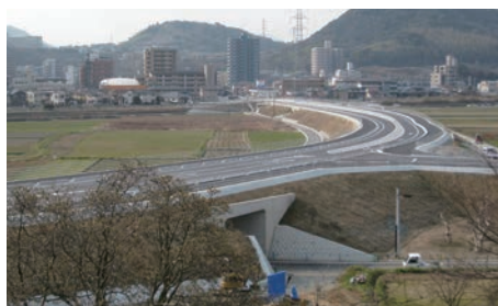
生活道路の整備(写真は市道 伊倉・有富線)
