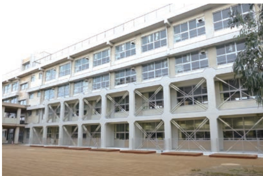
耐震化された小学校
