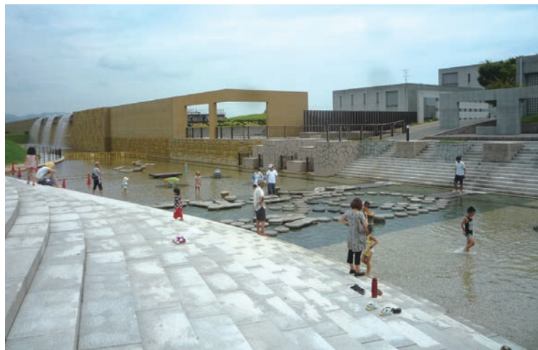
乃木浜総合公園親水広場(処理した水を再利用)
