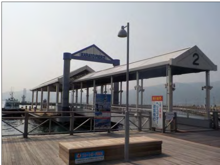
唐戸浮棧橋（2号） 利用状況： 不定期利用
