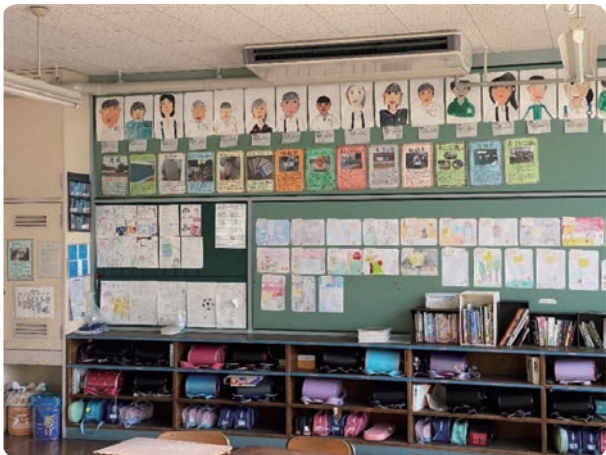
教室の空調設備の設置
