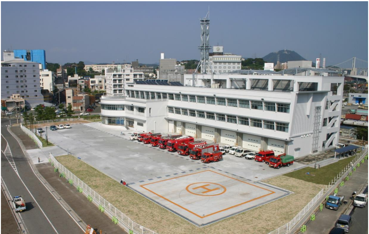
下関市消防局・中央消防署合同庁舎
