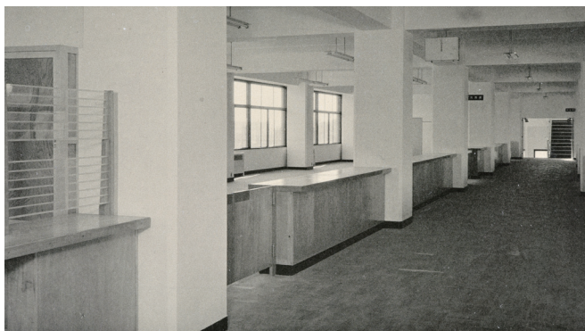
4階窓口カウンター
