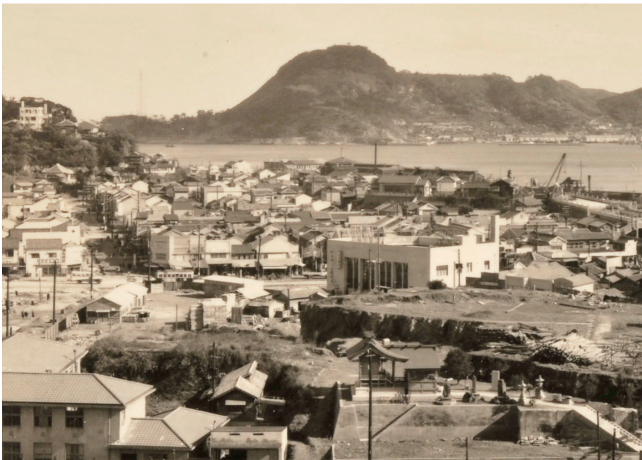
建設地(昭和28年12月頃)
