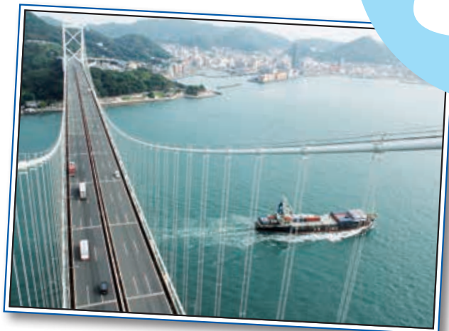
▲塔の高さは海面から141メートル。吊橋にかかる力を支えるケーブルは直径664ミリ、間隔29メートルで左右2本かけられています。
