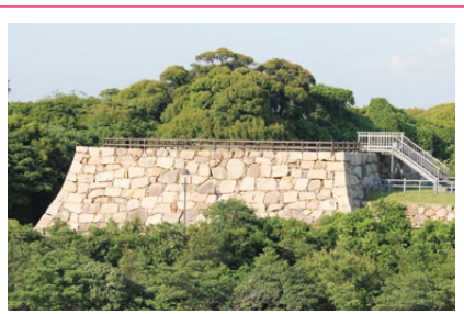
▲関門医療センターから見た櫛崎城石垣。平成7年度に復元されました。
