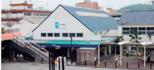
旧下関駅舎(平成17年撮影)
