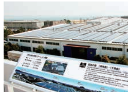
本社工場に設置された発電パネル。年間4,959メガワット時(一般家庭1,500世帯分)を発電します。
