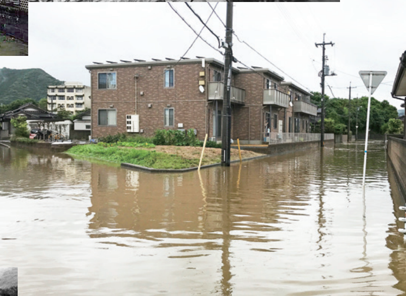
▲平成30(2018)年 安岡地区、冠水
