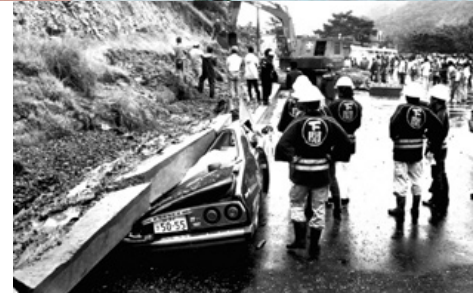
▲昭和57(1982)年 深坂自然の森付近にて土砂崩れ
