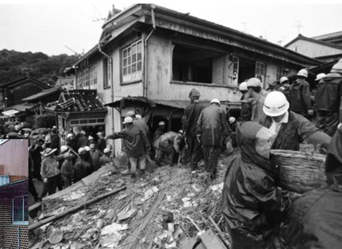
▼昭和47(1972)年 伊崎町、豪雨により土砂崩れ
