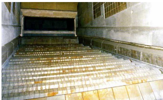
奥山工場 180t 炉乾燥帯（写真奥よりごみが供給される。）
