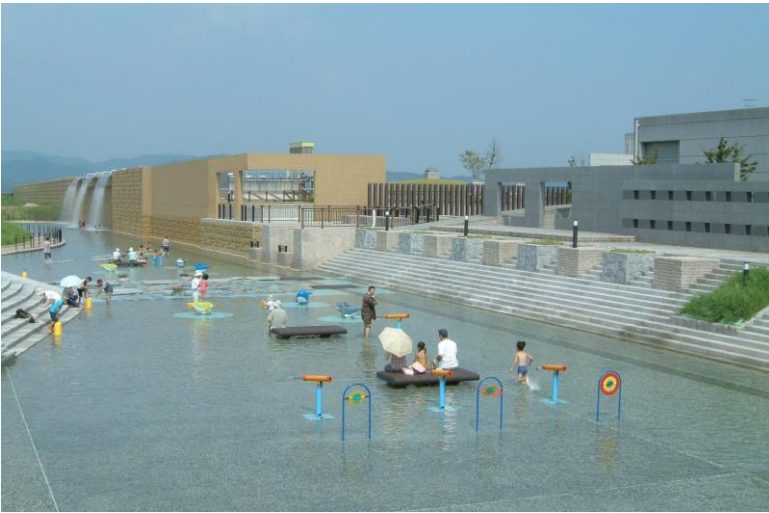
山陽終末処理場 隣接する乃木浜総合公園内の親水池に下水高度処理水を提供
