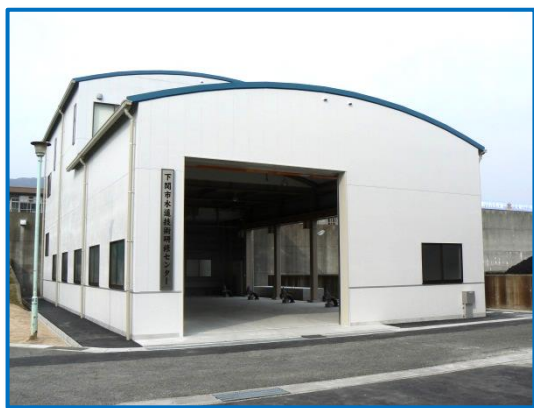
下関市水道技術研修センター
