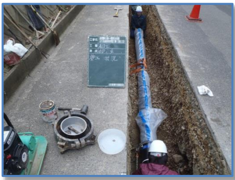
配水管の布設替え工事
