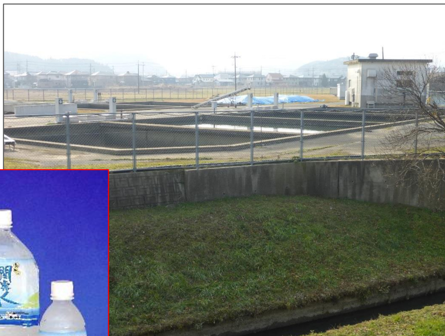
通常時の菊川浄水場
