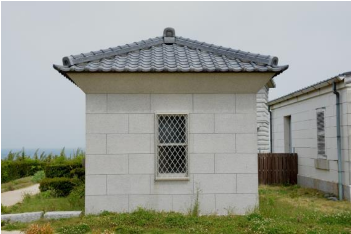
角島灯台 旧倉庫外観
