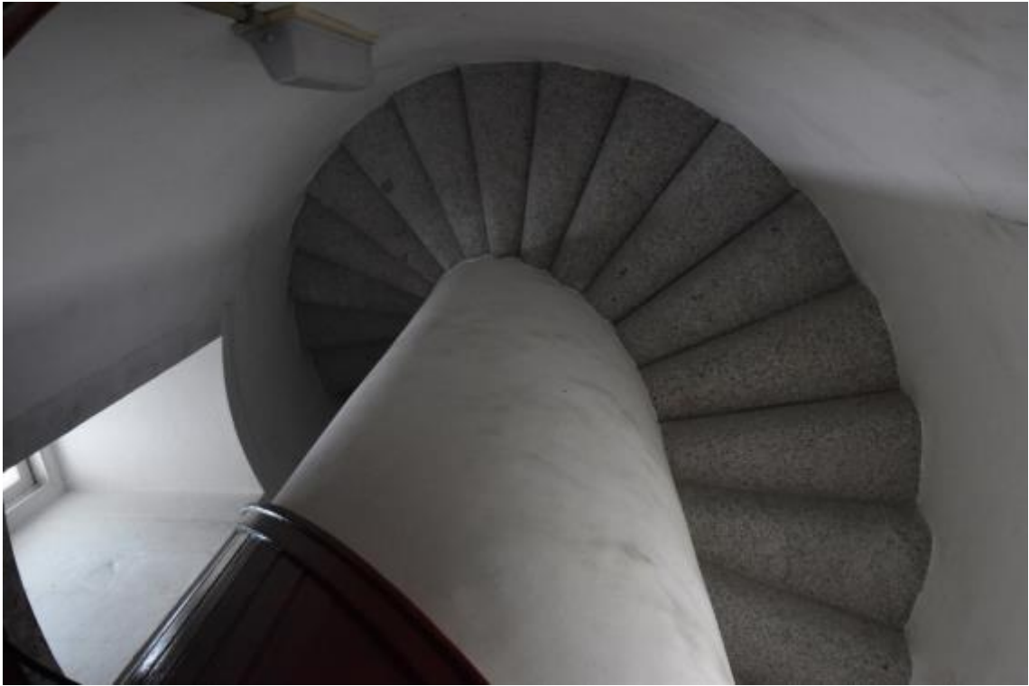
角島灯台 灯塔階段室見上げ
