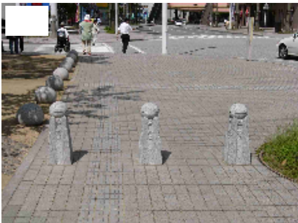
車止めの間隔が狭く、車椅子がギリギリ通れる程度
