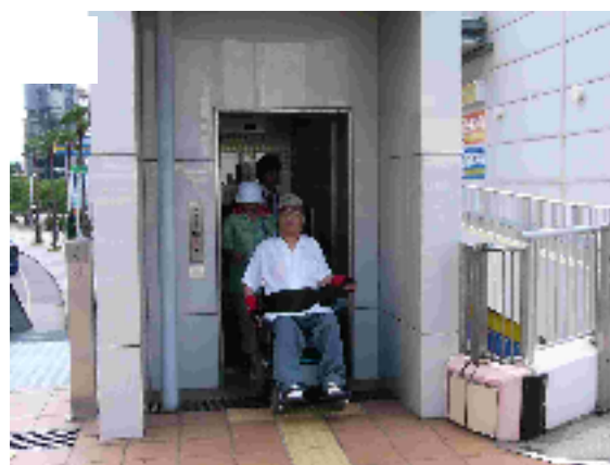
下関駅周辺の人工地盤のエレベーターは車椅子を転回させる必要がなく、移動に便利
