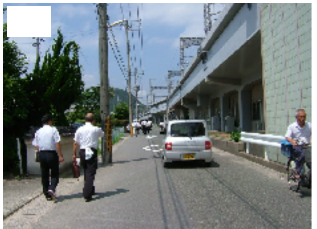
新下関駅周辺の道路には歩道があまりなく、車、歩行者、自転車がそれぞれ自由に通行しており危険
