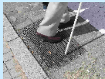
目の細かいグレーチング
