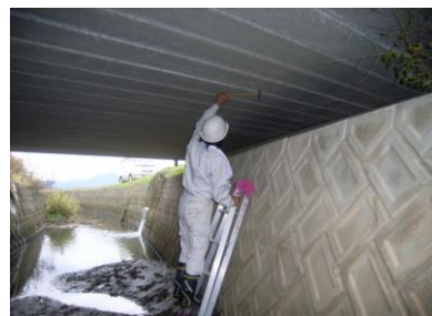
橋りょうの点検
