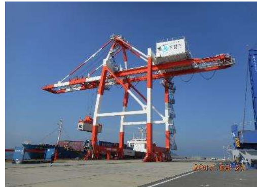
ガントリークレーン
