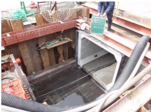
水路設置の様子
