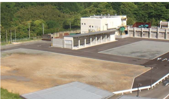
奥山工場ストックヤード
