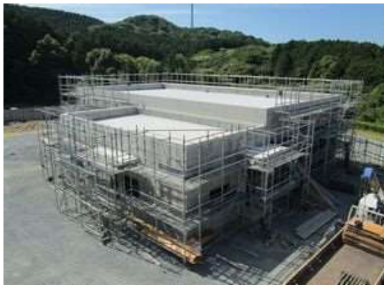
建設中の豊北中継貯留槽
