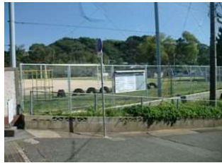
危険ブロック塀 撤去後（小学校）
