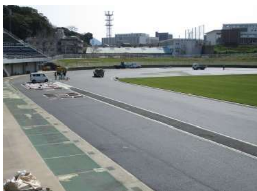
改修中の下関陸上競技場
