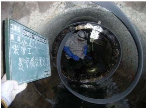
下水管内の様子
