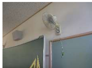
教室への扇風機の設置
