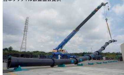
ダクタイル鋳鉄管（耐震継ぎ手）
