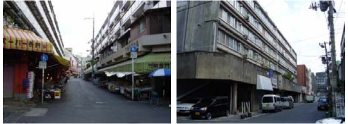
老朽化した竹崎改良住宅
