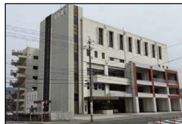
東消防署勝山出張所・下関市消防訓練センター
