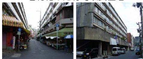
老朽化した竹崎改良住宅
