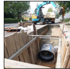
管の布設替工事
