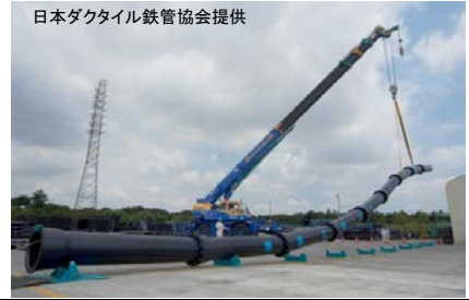
ダクタイル鋳鉄管（耐震継ぎ手）
