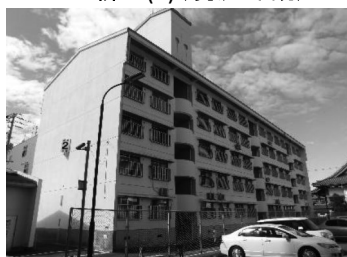
新地(2)(現況外観)
