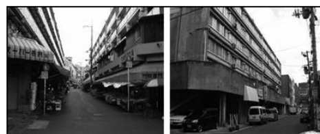
老朽化した竹崎改良住宅
