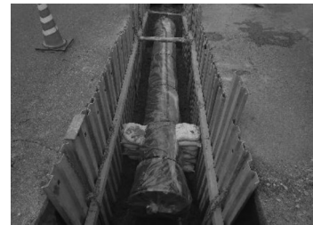
管の布設替工事
