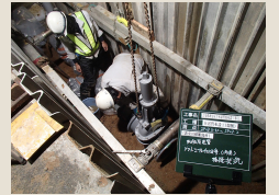
圧送管布設工事の様子
