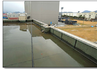
屋上コーキング
