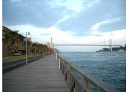
図 2-37 関門海峡に臨む水際に整備された ボードウォーク
