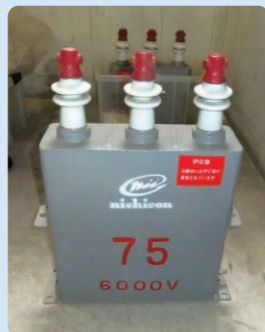
電力用コンデンサー
