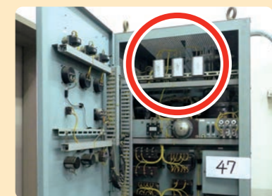
可変周波数電源装置に 取り付けられた低圧コンデンサー
