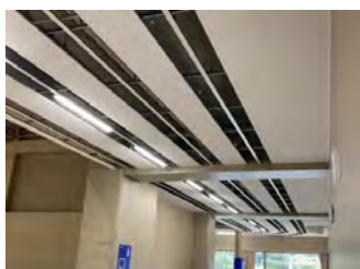
点検しやすさを 考慮した天井
