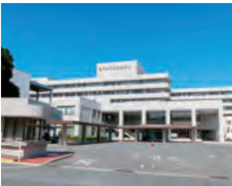
建築後34年経過した市立市民病院
