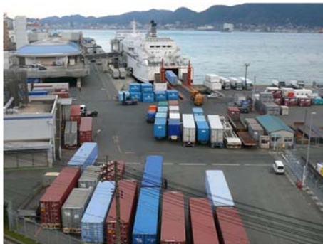
図 4-2 狭隘な背後地〔本港地区〕
