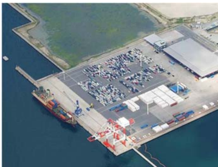
図 4-5 新港埠頭-12m岸壁利用状況
