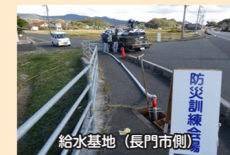
給水基地(長門市側) 道路に設置してある消火栓から給水タンク車へ補水しているところ。
