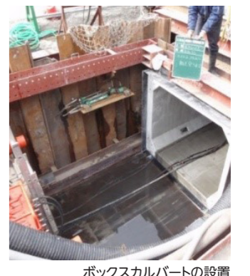
ボックスカルバートの設置
