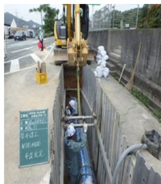
送水管布設工事
