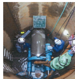
推進工法(立坑内部の様子)
