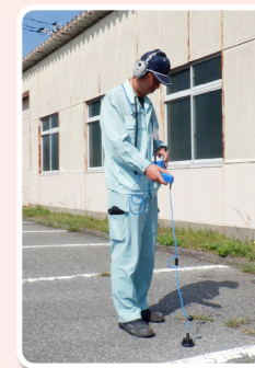
漏水探知機での調査
