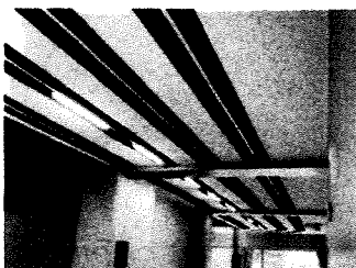
点検しやすさを 考慮した天井
