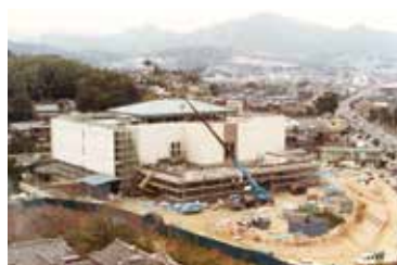
建設中の美術館
