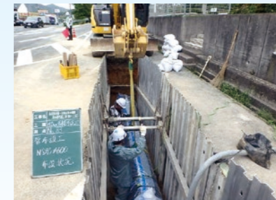
管路の更新工事
