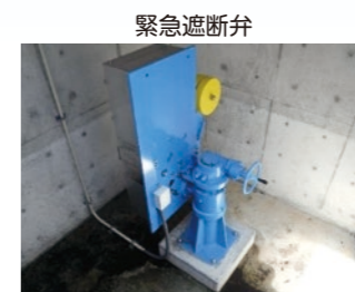
緊急遮断弁現場操作盤
