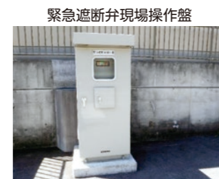
緊急遮断弁現場操作盤
