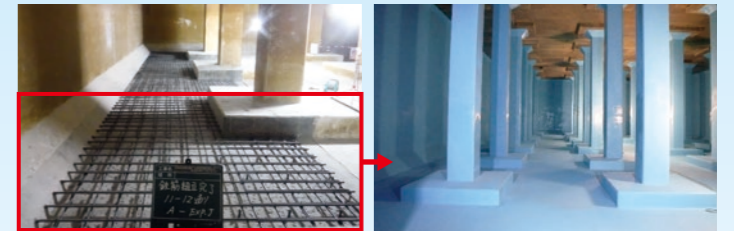
配水池耐震化工事中
