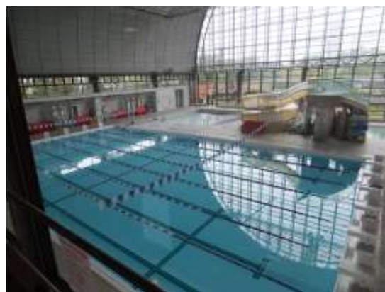
【屋内温水プール】
