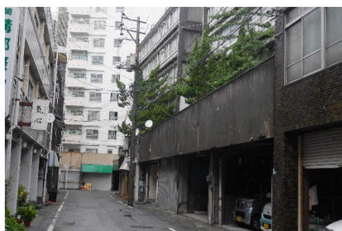
竹崎団地 2 階部分
