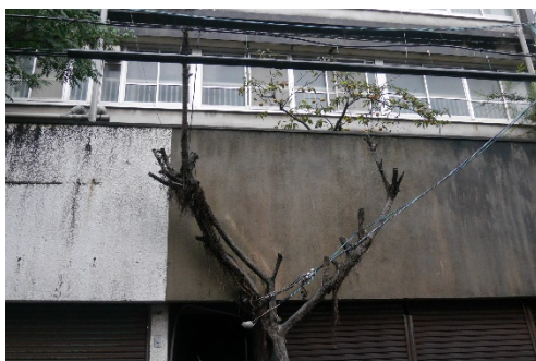
竹崎団地 1 階部分
