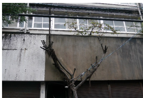
竹崎団地 1 階部分
