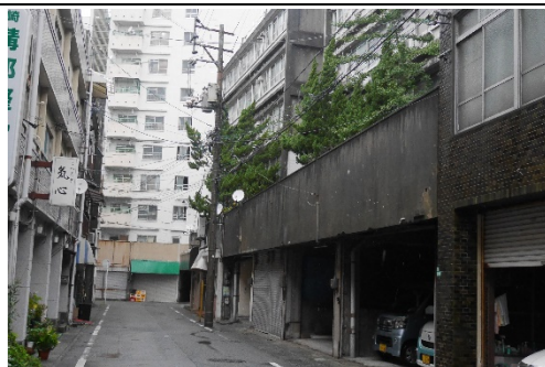
竹崎団地 2 階部分
