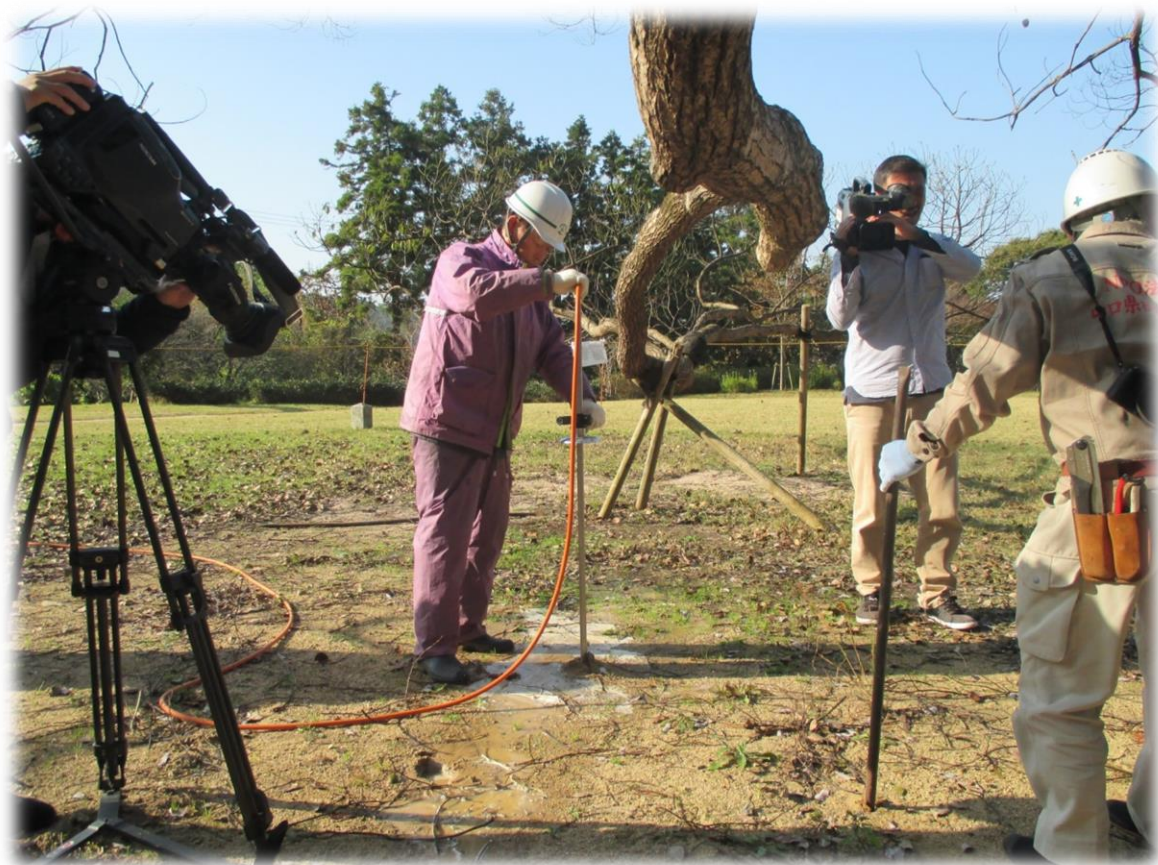
平成 29 年 (2017 年) 11 月水圧穿孔法による土壌改良実施《1 回目》
