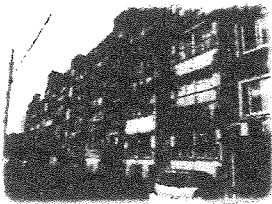
老朽化した住宅
