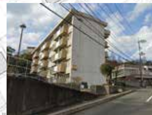
①改良(1)棟の外観
