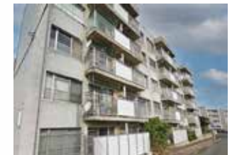
④ 改良(2)棟の外観
